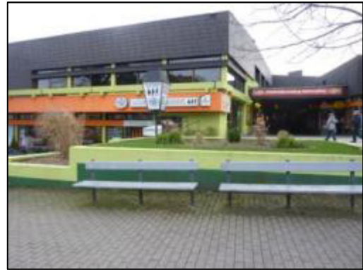
Abb. 5: Talstation an der Rathausstraße
