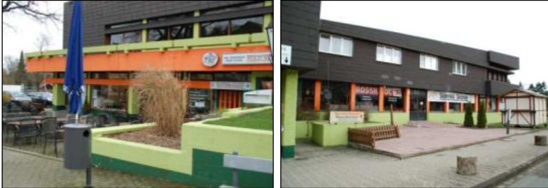
Abb. 52 und 53: Möblierung an der Talstation
