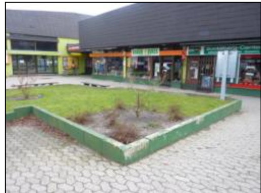
Abb. 41: Hochbeete an der Talstation
