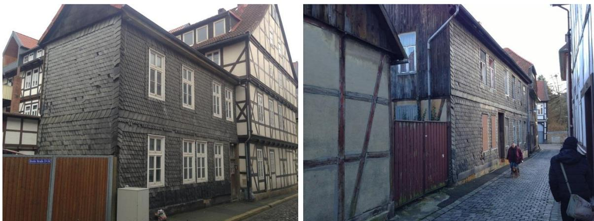
Abbildung 31: Erhebliche Schäden an Fassaden und Verkleidungen
