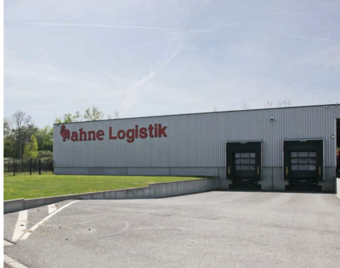
Abb. 6.3/11 Hahne Logistik im Gewerbegebiet Güterbahnhof
