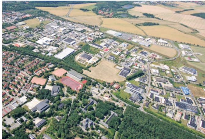
Abb. 7.3/1 Gewerbegebiet Baßgeige, Blick Richtung Südwesten
