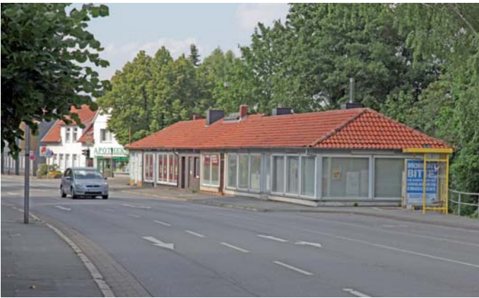
Abb. 7.3/4 Ehemalige »Okerpavillons« an der Talstraße: nach Abriss kann nun räumlicher Bezug zur Oker geschaffen werden
