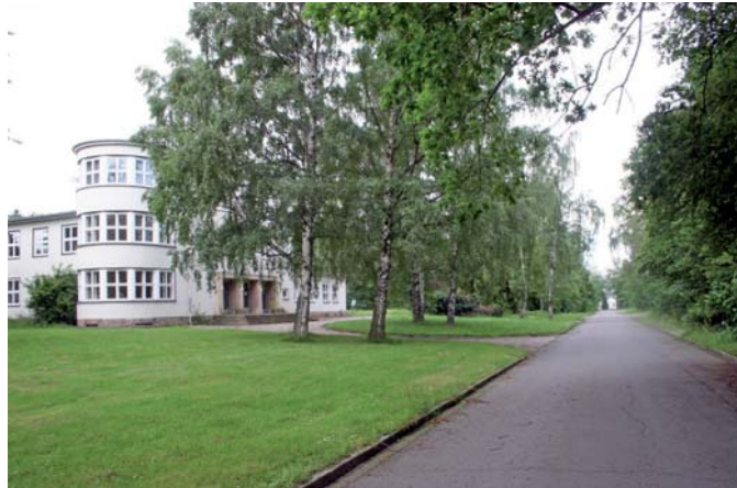
Abb. 7.2/11 ehemaliges Kontrollgebäude [Gebäude 44]
