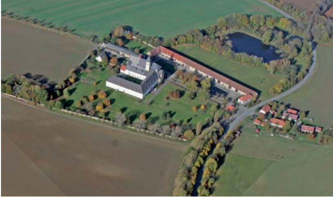
Abb. 3.1/18 Gut Grauhof von Südosten
