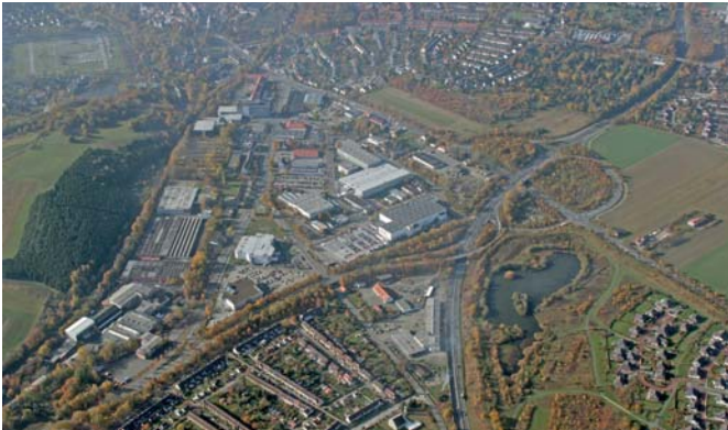
Abb. 3.1/26 Gewerbegebiet Gutenbergstraße von Osten
