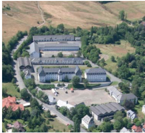
Abb. 2.7/2 Campus in der ehemaligen Rammelsbergkaserne
