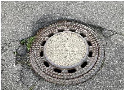
Abgesackter Gullideckel mit Sturzgefahr
