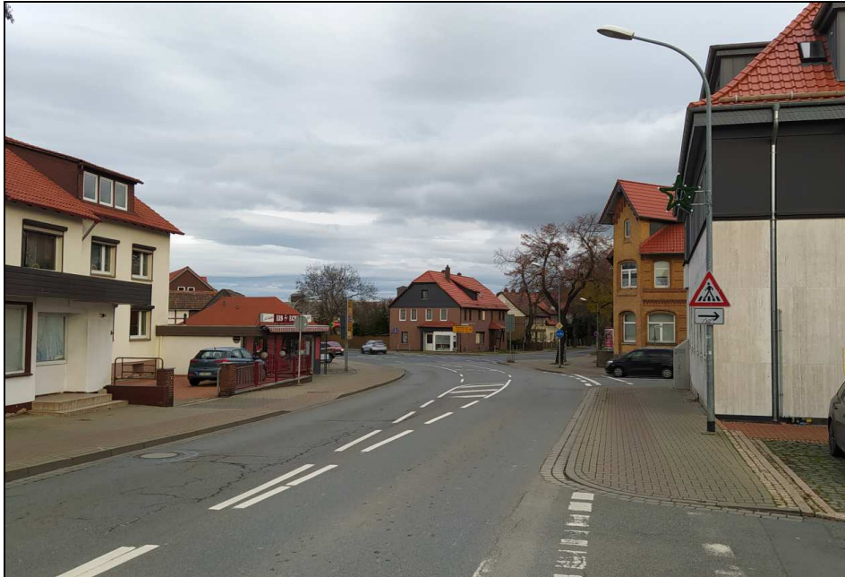
Abbildung 13: Betroffene Wohngebäude an der Wiedelahaer Straße (B241) in Vienenburg (Foto: LÄRMKONTOR)
