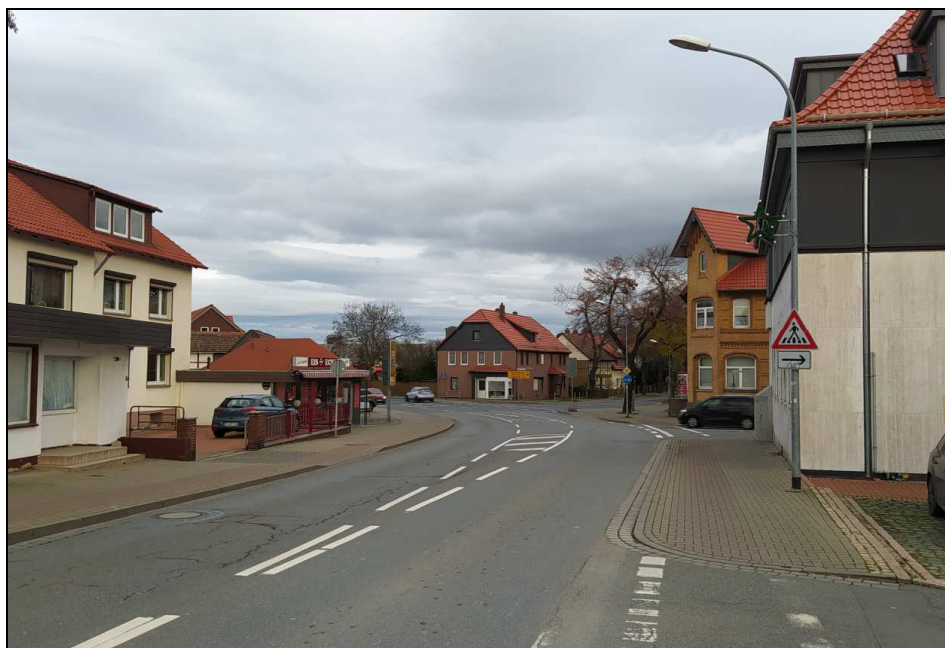
Abbildung 13: Betroffene Wohngebäude an der Wiedelahr Straße (B241) in Vienenburg (Foto: LÄRMKONTOR)
