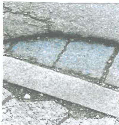
Schäden im Pflaster können den Spaziergang für Menschen mit Rollator zum Balanceakt machen.
